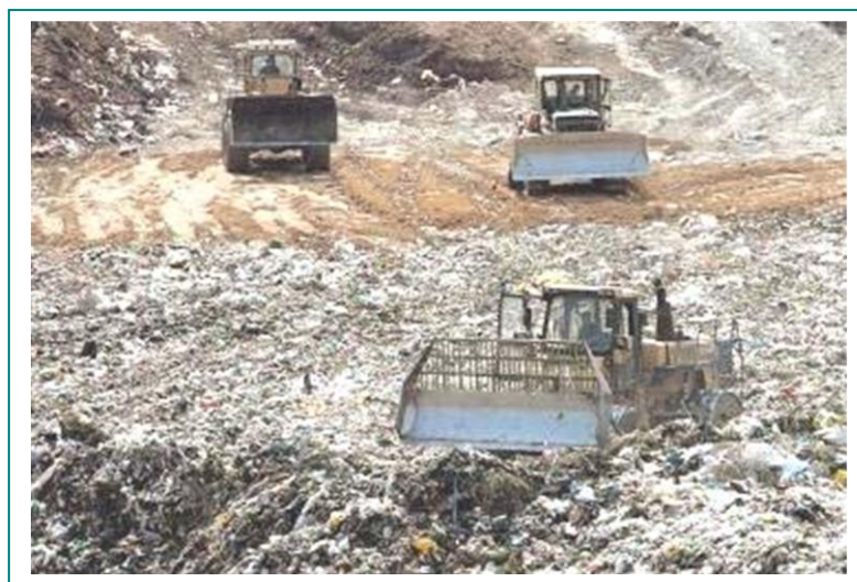
Слика бр.VIII-1: Компактирање на отпадот и негово покривање со земја
